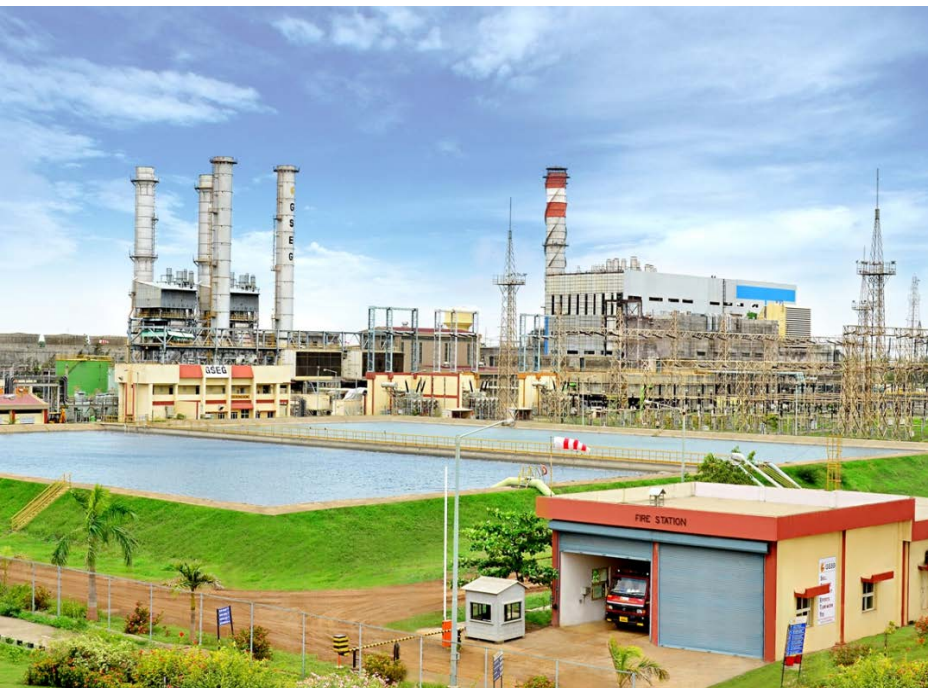
GuD-Kraftwerk Hazira in Gujarat, Indien
